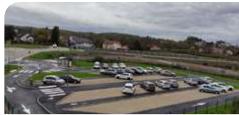
Parking de covoiturage - Site de l'échangeur n°11, entre l'A36 et la RN1019 - 2022
