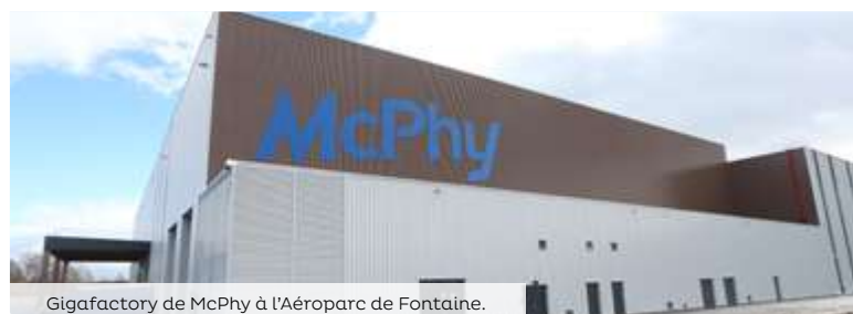
Gigafactory de McPhy à l'Aéroport de Fontaine.
